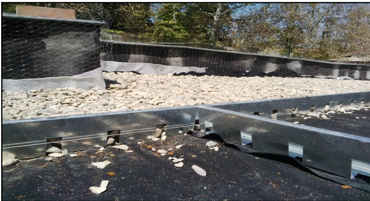
شکل پ. ۱-۱۱- اجرای توری بر روی بدنه جان پناه
