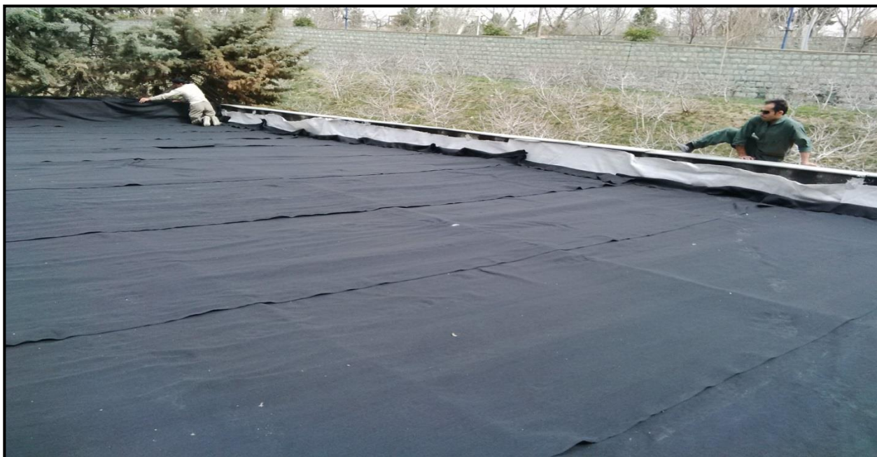
شکل پ.۱-۹- قرار دادن لایه ژئوتکستایل صافی؛ پهن کردن این لایه با هم‌پوشانی ۱۰ سانتی‌متری بر روی سقف صورت می‌گیرد. این لایه در بدنه عمودی جان‌پناه امتداد می‌یابد و توسط توری ثابت شده و روی آن ملات ماسه سیمان اجرا می‌شود.
