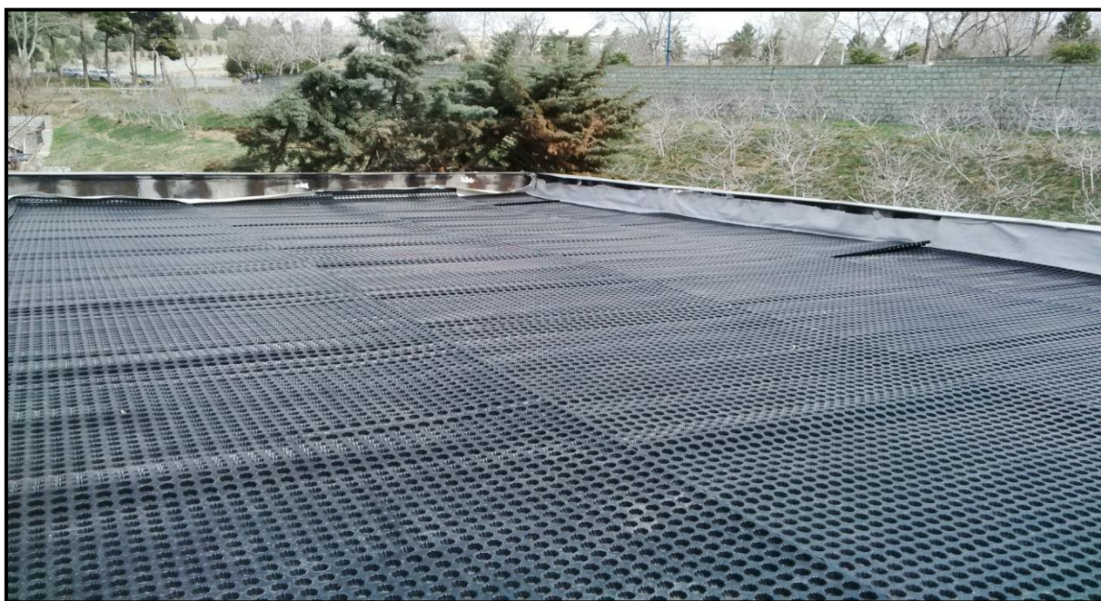
شکل پ. ۱-۸- قرار دادن لایه زهکش؛ پهن کردن این لایه با هم پوشانی ۱۰ سانتی متری بر روی سقف صورت می گیرد. برای این منظور حفره ها در یکدیگر جاگیر می شوند.
